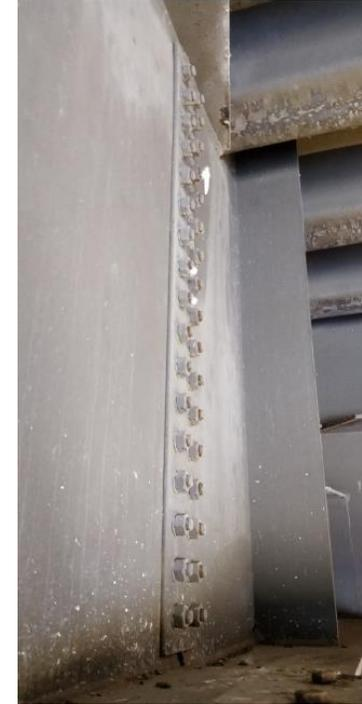
**Bipoutre à dalle orthotrope 1972 (soudure en atelier, assemblage par boulons précontraints sur site)**
