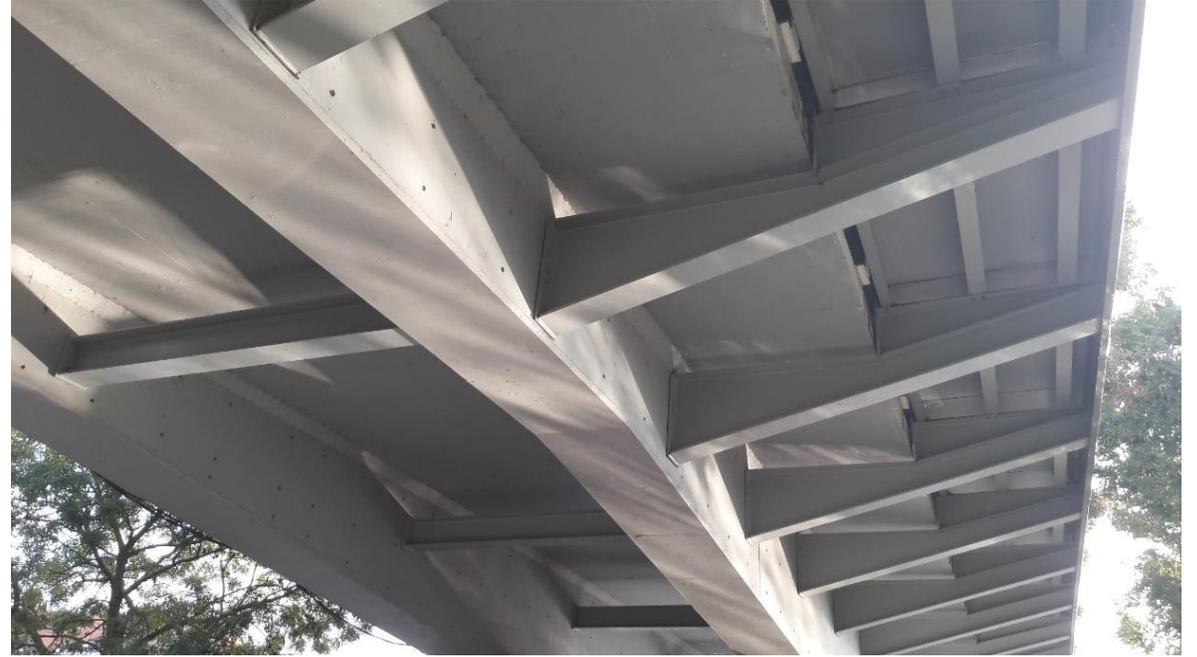
*Elargissement d'un tablier à poutres en béton précontraint par un encorbellement métallique sur consoles*
