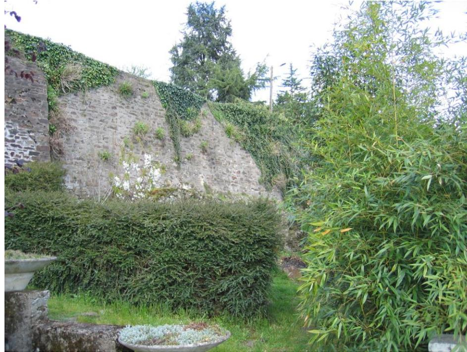
*Mur en maçonnerie de pierres jointoyées*
