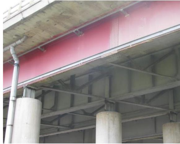
**Multipoutres mixtes 1970 (soudure en atelier, assemblage riveté sur site, entretoises triangulées)**
