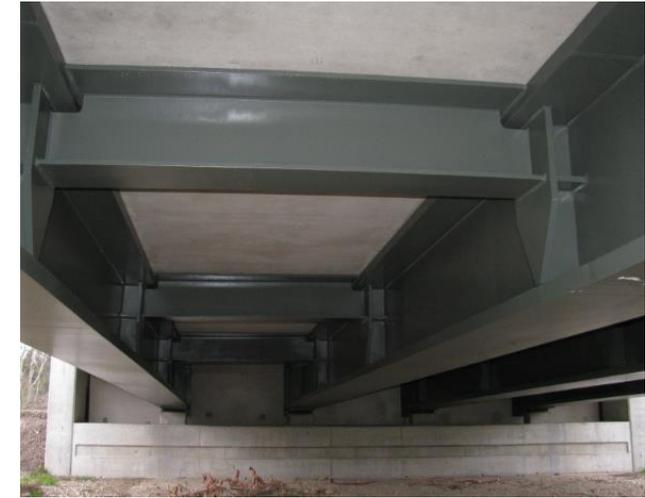
**Multipoutres mixtes 2017 (soudures en atelier et sur chantier)**
