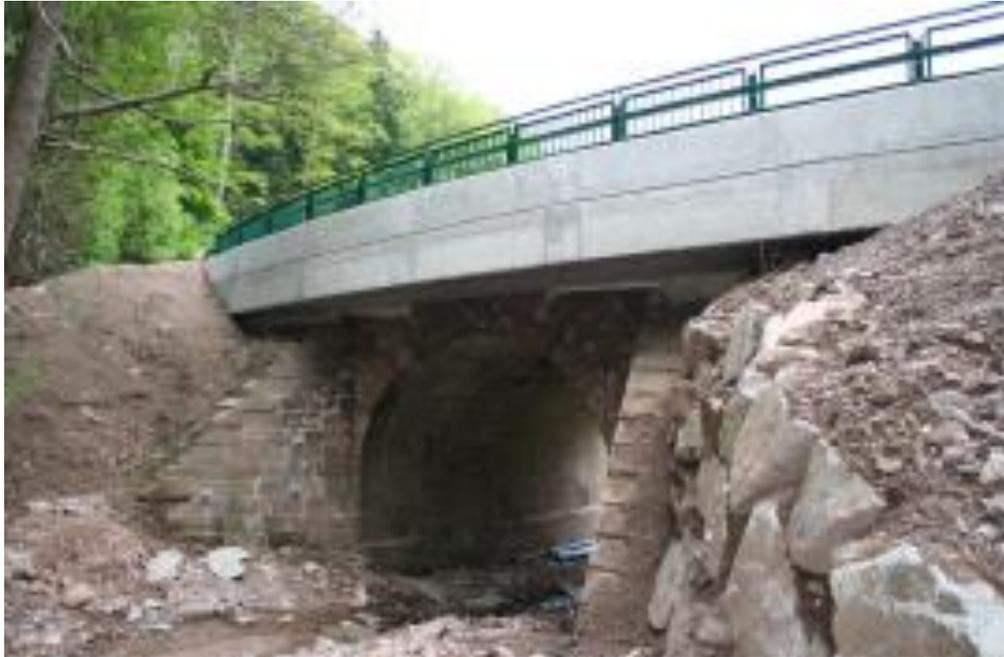
*Elargissement d'une voûte en maçonnerie par une dalle en béton armé posée*
