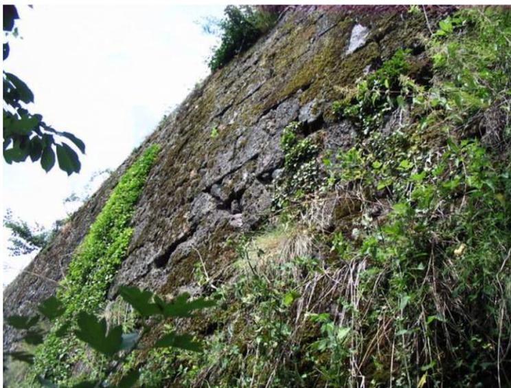
*Bombement de maçonnerie avec disjoiement*
