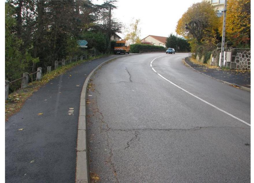
*Partie supérieure d'un mur : fissuration de la chaussée, défaut d'alignement des dispositifs de retenue*
