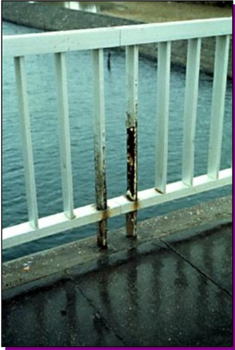
*Corrosion des éléments de garde-corps*
