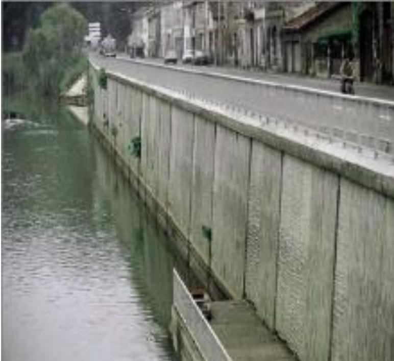
*Mur en béton armé encastré sur semelle*
