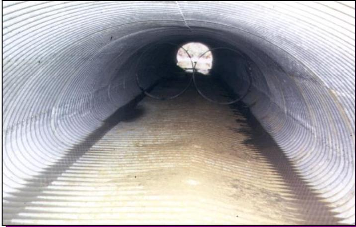
*Inversement de la courbure du radier d'une buse métallique*
