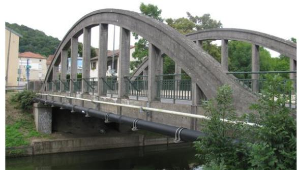
1953 - suspentes et pièces de pont plus épaisses
