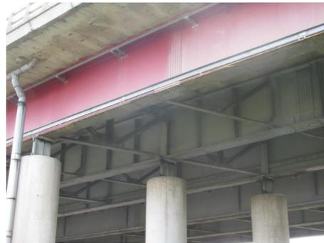
1970 - soudure en atelier, assemblage riveté sur site, entretoises triangulées
