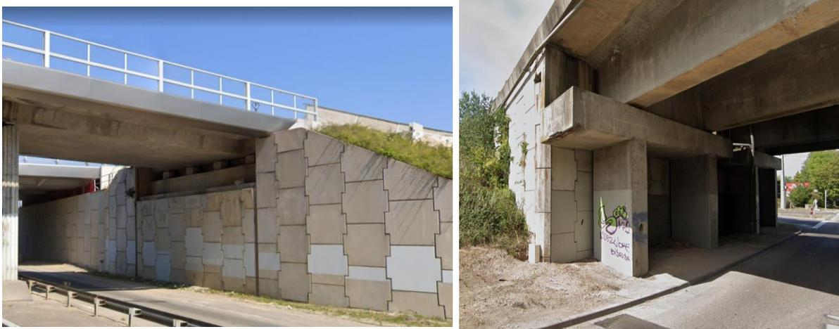
Figure 22 : Exemple de culées en Terre Armée
