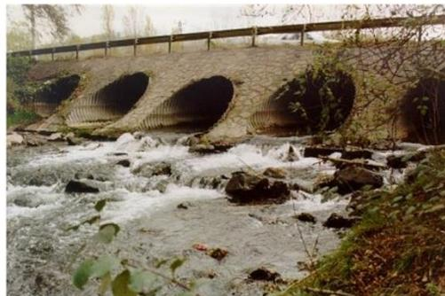
Figure 23 : Exemple de buse multiple
