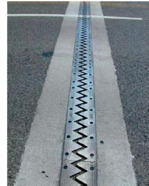
Exemples de joints mécaniques
