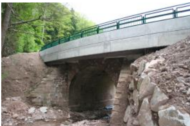
Élargissement d'une voûte en maçonnerie par une dalle en béton armé posée
