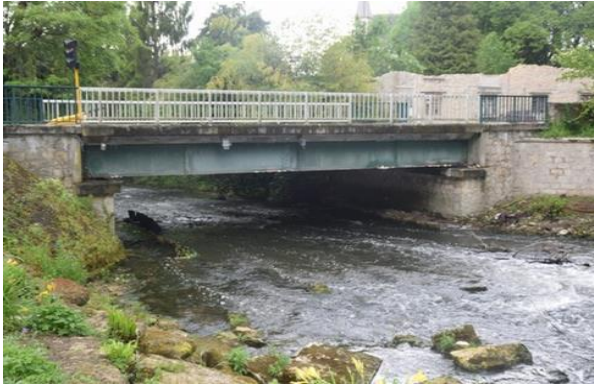
Photo d'ensemble centrée sur l'ouvrage
