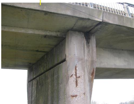
Exemple de pile-culées
