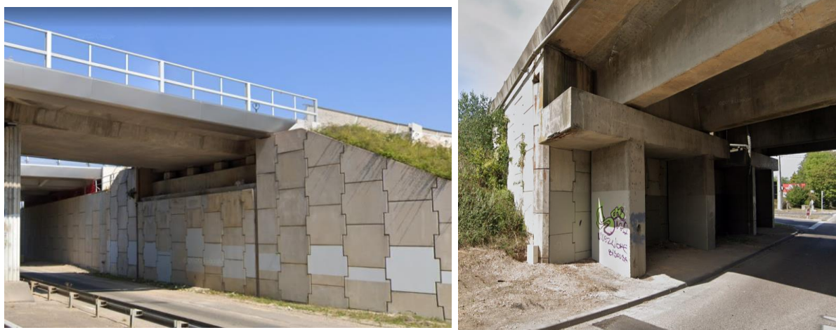
Figure 22 : Exemple de culées en Terre Armée
