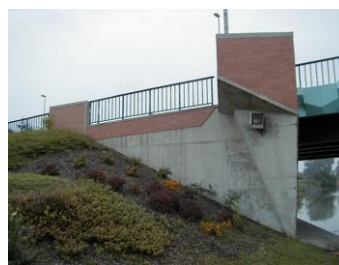
Exemple de culées avec mur de front
