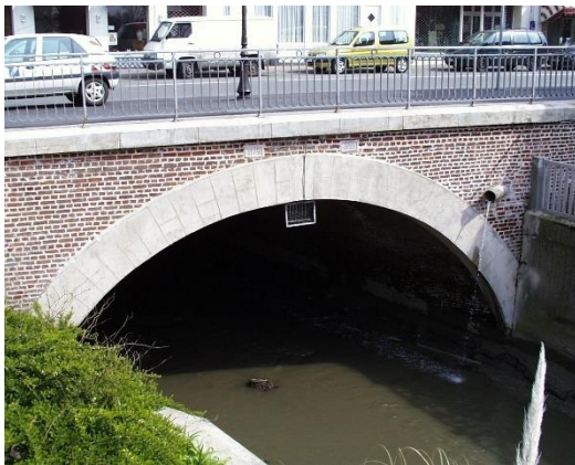
Voûte en maçonnerie à arche unique
