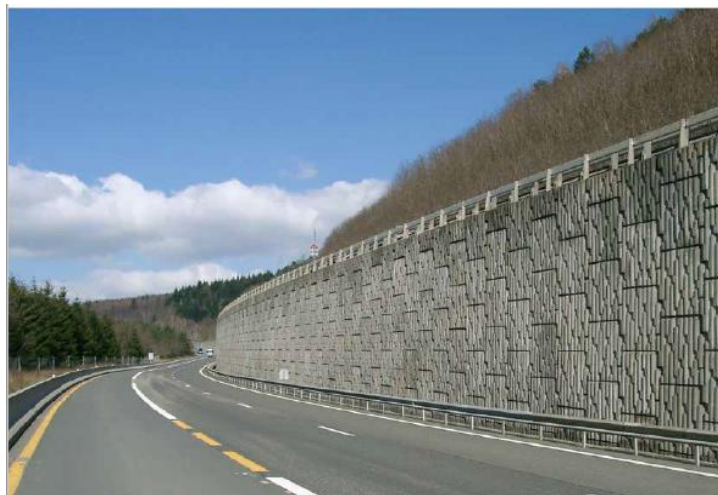
Figure 25 : Exemple de mur en Terre Armée
