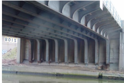
1946 – bacs en acier coffrant le béton
