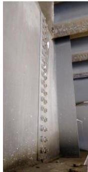
1972 - soudure en atelier, assemblage par boulons précontraints sur site
