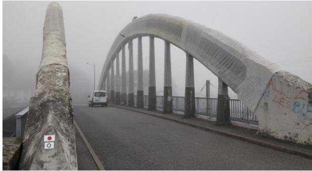
1926 – suspentes et pièces de pont fines
