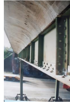
1937 - hourdis en béton mince, piles métalliques très fines
