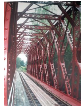
1920 - Aciers doux, rivets et boulons, longerons
