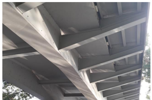
Élargissement d'un tablier à poutres en béton précontraint par un encorbellement métallique sur consoles
