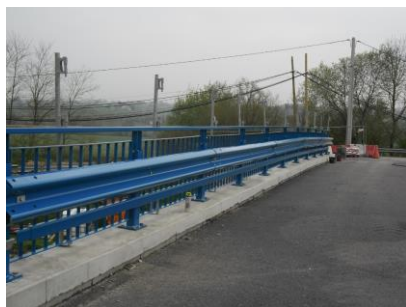
Garde corps + glissière
