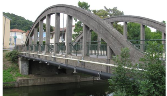
1953 - suspentes et pièces de pont plus épaisses
