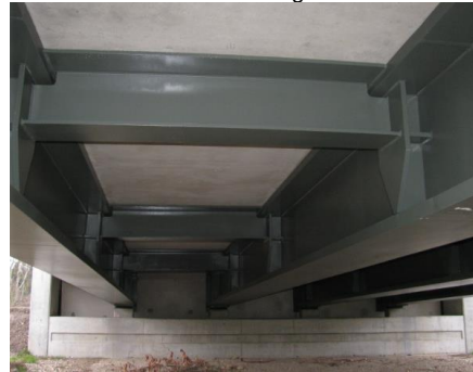
2017 - soudures en atelier et sur chantier, dispositions constructives plus épurées
